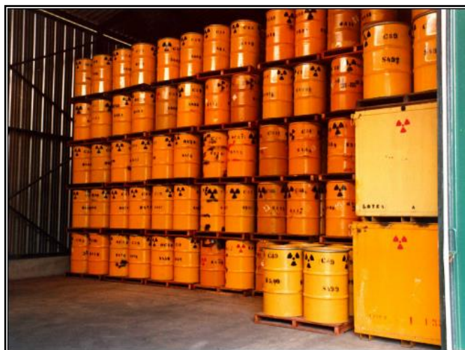
Figura 18: Depósito provisório de rejeitos radioativos do Instituto de Pesquisas Energéticas e Nucleares - IPEN. Fonte: MARUMO, 2006.
