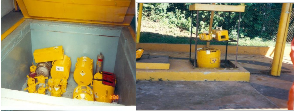
Figura 15: Local de armazenamento de fontes radioativas Fonte: AIEA, (2005a)
