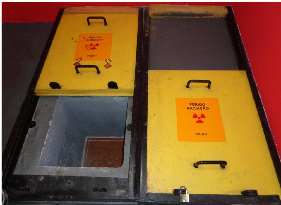
Figura 15 – Exemplo de poço blindado de armazenagem de fontes, com cadeados e sinalização.
