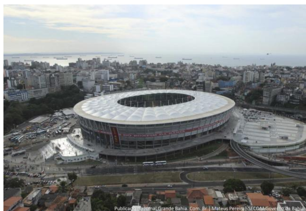
Figura 2 – Estádio Arena Fonte Nova 10
