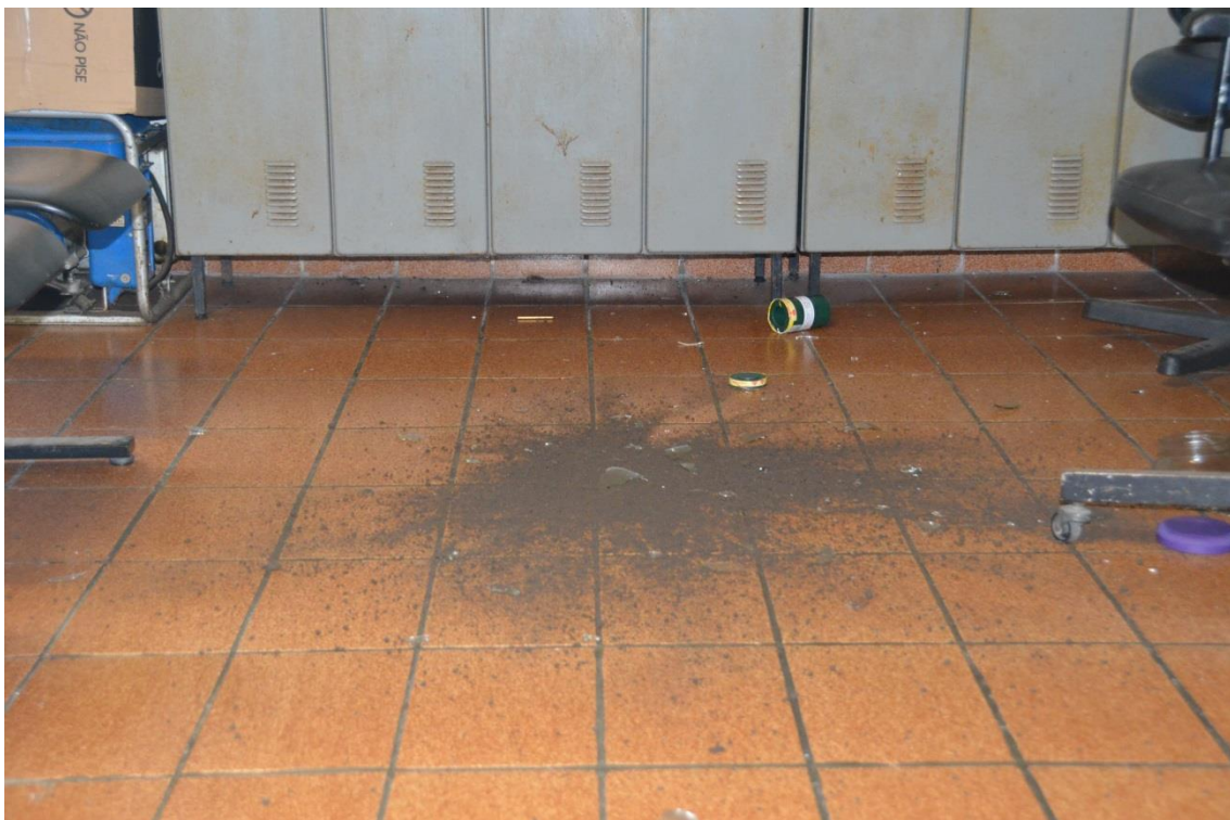
Figura 24: Fotos do Acidente Radiológico no Banheiro
